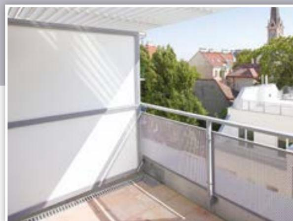
Le THERMIPAN GC CTBH avec âme bois. Il peut être utilisé dans les meilleures conditions pour le remplissage de menuiserie comme pour les systèmes de retenue des balcons.
